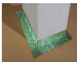
Cheminée / fenêtre de toiture
