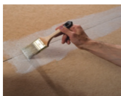
Déposer le primer PAVAPRIM sur les panneaux avec la bouteille verseuse et l'étaler avec un pinceau ou un rouleau
