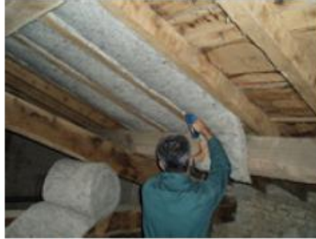
Isolation sous rampants
