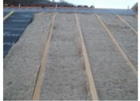
Mise en oeuvre par l'extérieur
